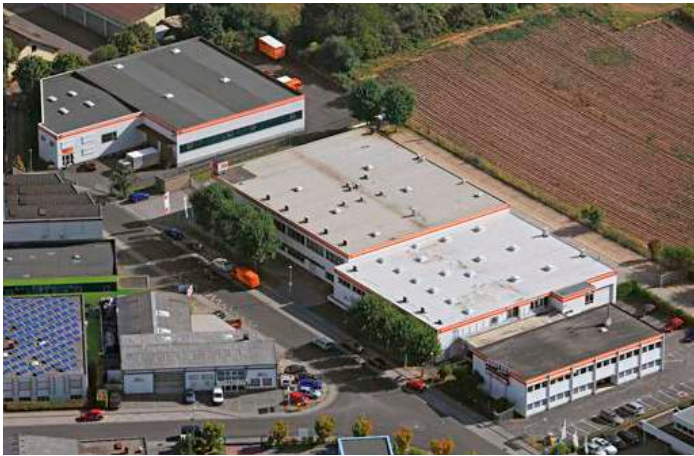
Główna fabryka w Hofheim pod Frankfurtem, Niemcy
